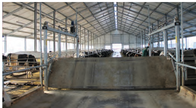
W oborze zastosowany jest most zwodzony, dzięki któremu, udając się do hali udojowej, krowy nie przechodzą przez stół paszowy
