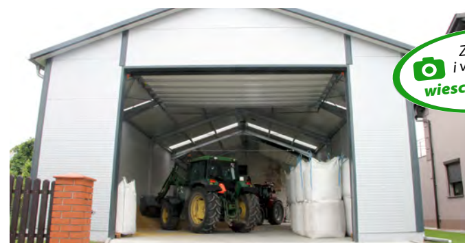
Wybudowanie magazynu kosztowało 300 tys. zł. - Nie ma tutaj ścian betonowych, a płyty. Nie nasypimy więc zboża pod samą górę. Będziemy tutaj składować paszę i przechowywać maszyny - opowiada Robert Marciniak.
