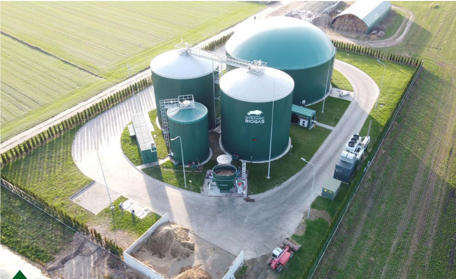
Biogazownia rolnicza Śniaty o mocy 0,5 MW, przerabiająca odchody od 300 krów mlecznych.
