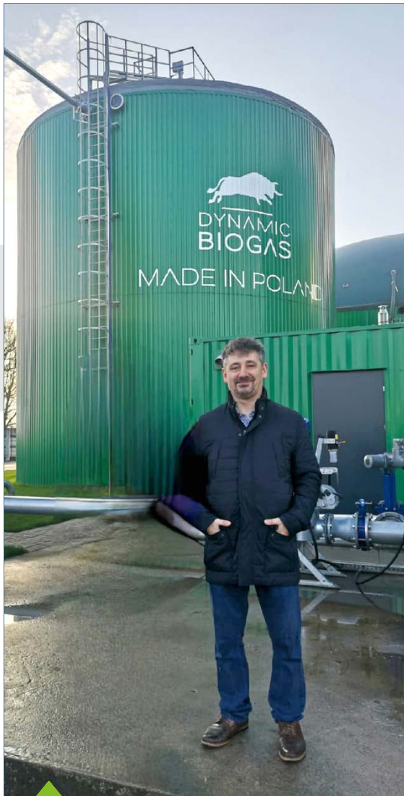
Prof. dr. hab. inż. Jacek Dach, kierownik Pracowni Ekotechnologii UP w Poznaniu, podczas wizyty w biogazowni zainstalowanej w Przybrodzie
