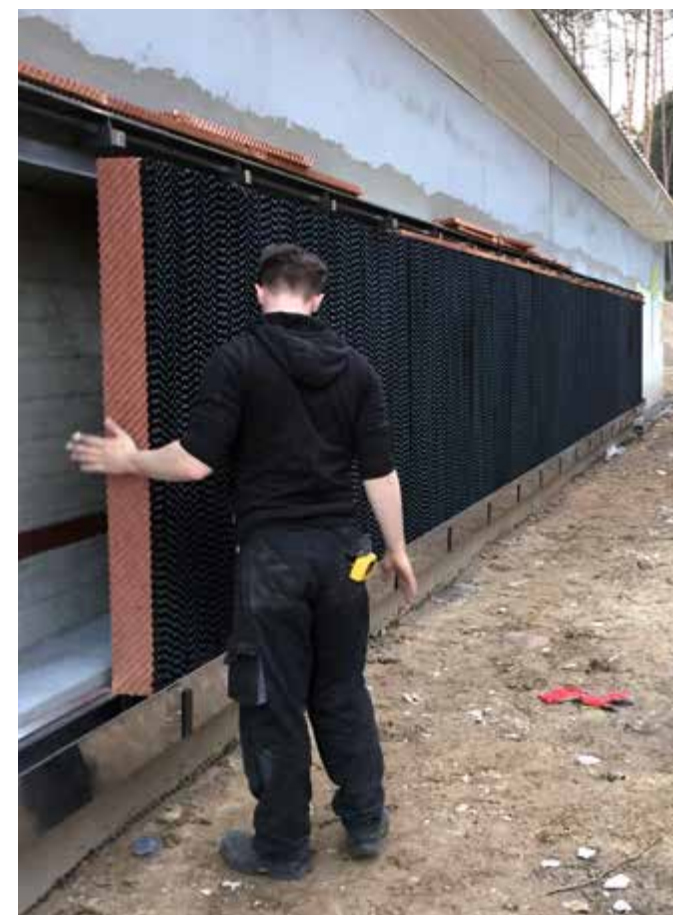
Montaż paneli Pad Cooling w kurniku
