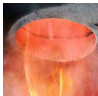
Komora spalania gazów i pyłów
