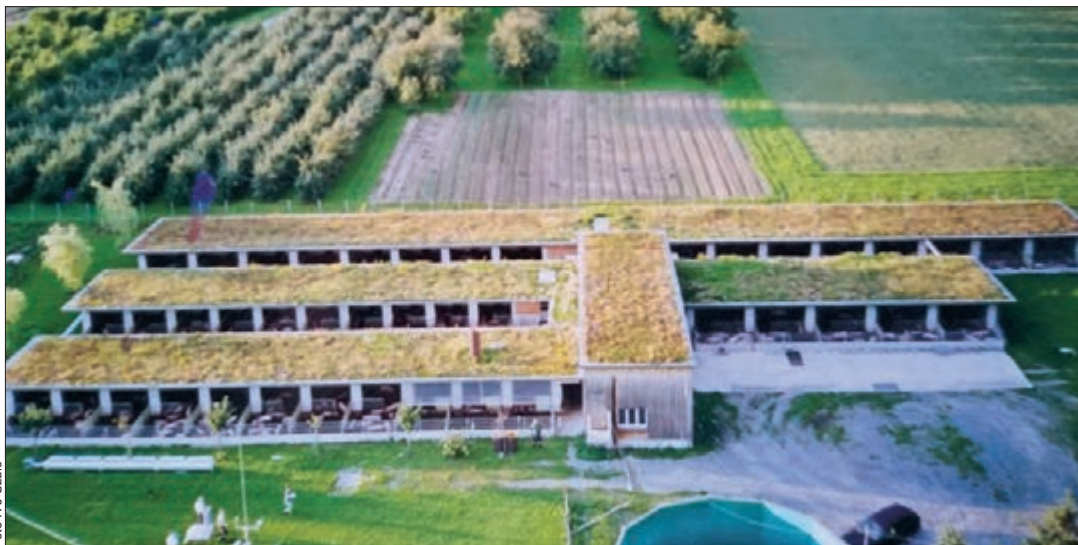
Trawa na dachu chlewni to dobra izolacja
