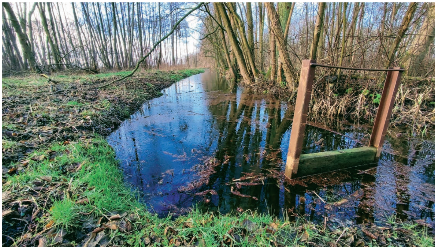
▲ Proste urządzenia hamujące odpływ z sieci melioracyjnej pozwalają na zmagazynowanie ogromnych ilości wody przy niewielkim nakładzie finansowym
