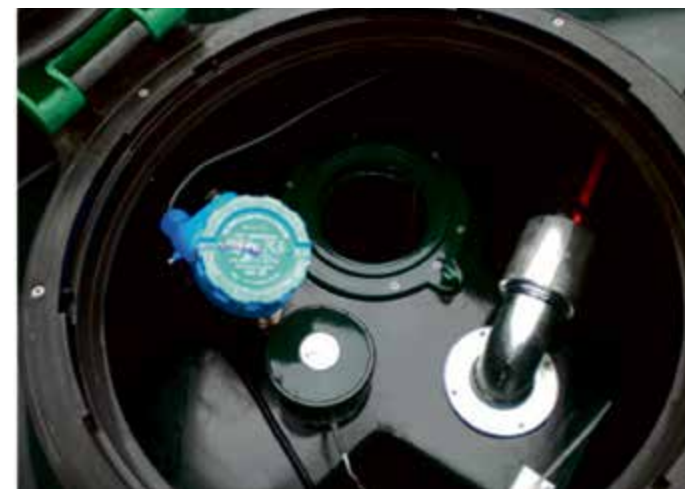
Fot. 3. Właz rewizyjny w zbiorniku wraz z zestawem czujników poziomu paliwa oraz monitoringu szczelności
