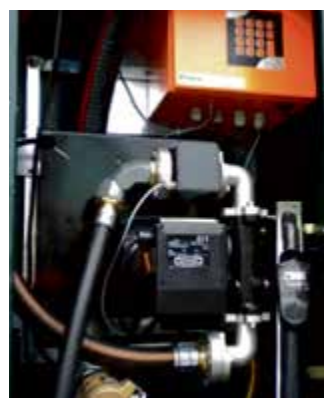
Fot. 2. Zespół dozująco-pomiarowy; jednostka sterująca, pompa elektryczna, linia napełniająca, nalewak
