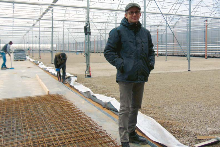
Pan Marcin skrupulatnie realizuje kolejne pomysły na rozwój działalności - na ukończeniu jest kolejna szklarnia, która ma nowoczesne rozwiązania i technologie, unikatowe w skali kraju
